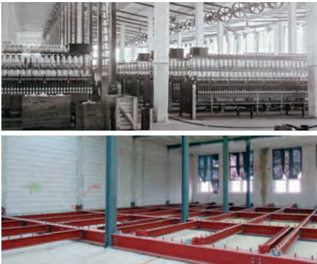
Bild 3: Einbau von Stahlträgern, die den Boden des 3. Obergeschosses verstärken (Universität Bayreuth)
